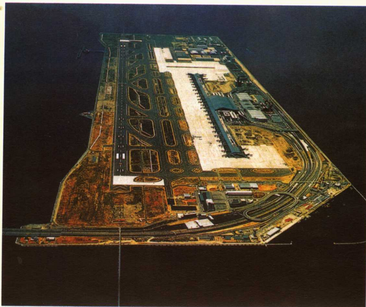
日本关西国际机场位于海洋中的人工岛上。该建筑物是由数百根插入大量混凝土中的钢柱支撑的，可以随岛屿位置的移动而向上顶起或落下。
