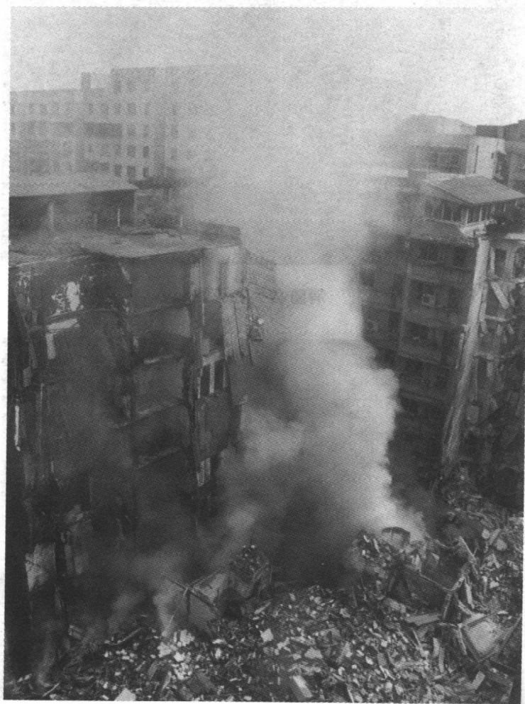
火灾坍塌事故现场
