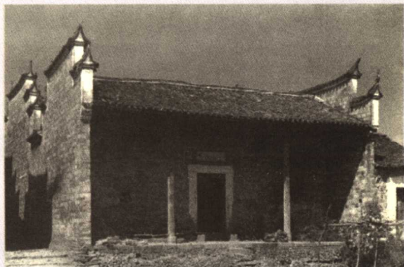
宁都会会议旧址（宁都县东山坝小源村榜山翁祠）
