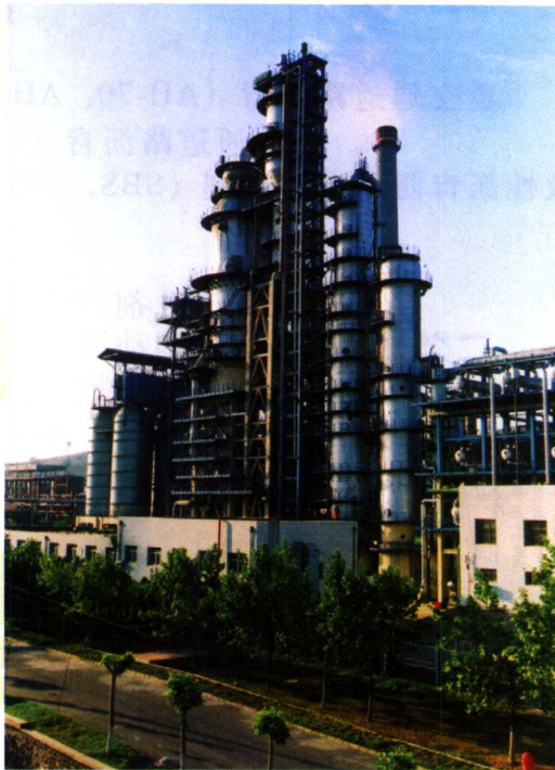
140万吨/年重油催化裂化装置
