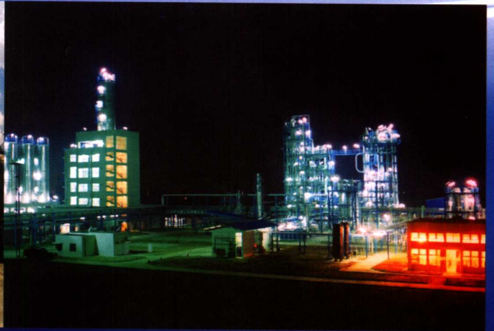
10万吨/年 聚丙烯装置
