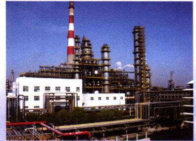
500万吨/年三套常减压装置
