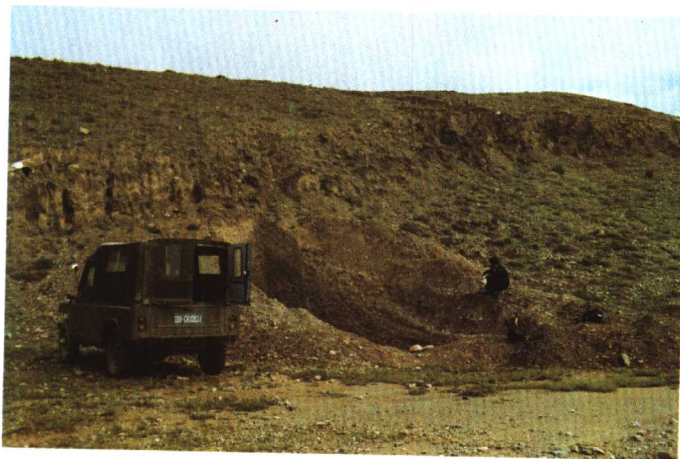
照片23 沿邵水拉分盆地西缘的北东向边界正断层形成的断层崖及沿断层崖开挖的探槽。镜头向北西 (张维歧摄)
