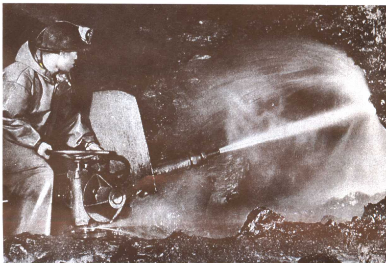
使用人力清砂机 清除矽尘。
