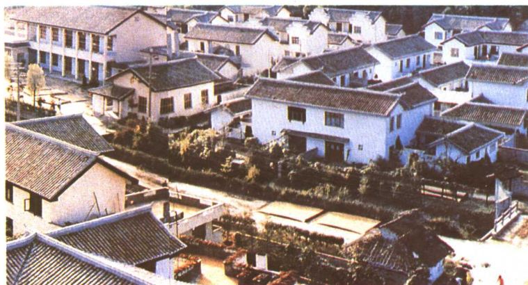
四川省温江县永宁村建起庭园式楼房、自来水、沼气池和节能无烟灶等配套设施。
