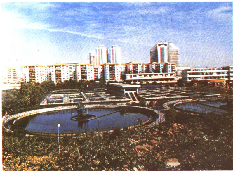
深圳市已建成现代化的污水厂,每日无害化处理污水2.5万立方米。
