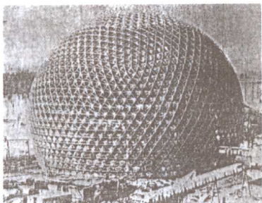
图1.1.9 蒙特利尔短程线型双层网壳 ( D=76\text{m} )
