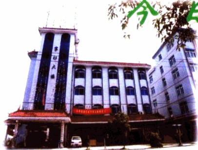
建于1998年的宁村村委大楼
