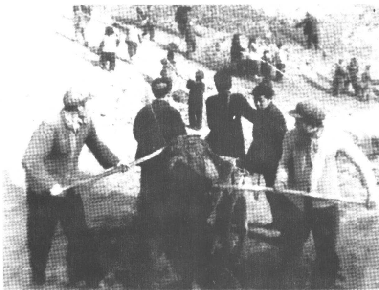
翻淤封闭沙丘——给沙丘“贴膏药”。
