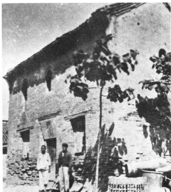
照片 2-5 解元集村唯一的一座未倒楼房， 但发生裂缝(据李群 1969 年资料)
