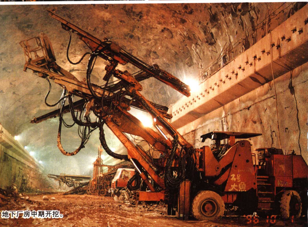
精诚合作，严把关，监理工程师在三标消力池竖井施工现场了解施工进度和施工质量。
