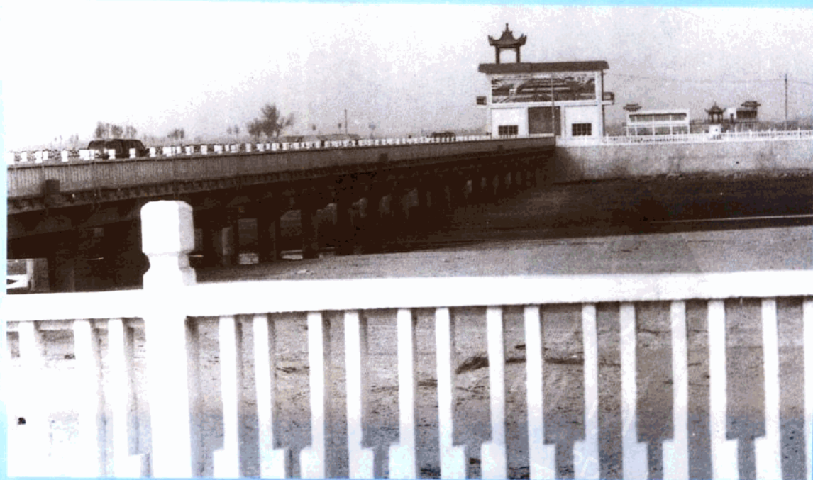
▽ 农一师塔南总干渠跨和田河配套工程。(1996年)
