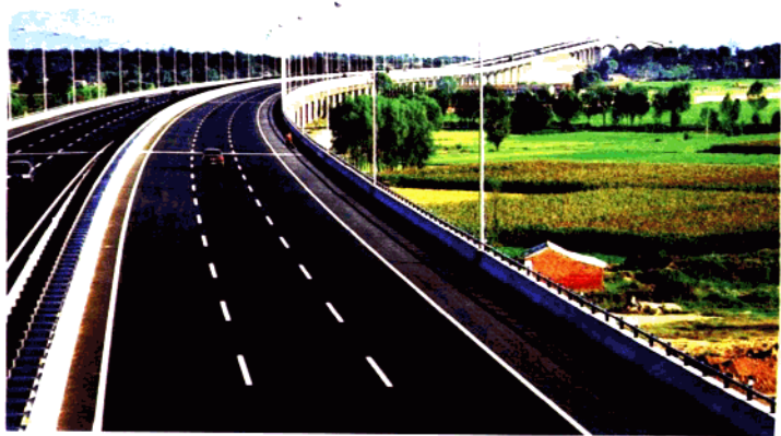
济德高速公路济南黄河大桥（又称“黄河二桥”）
