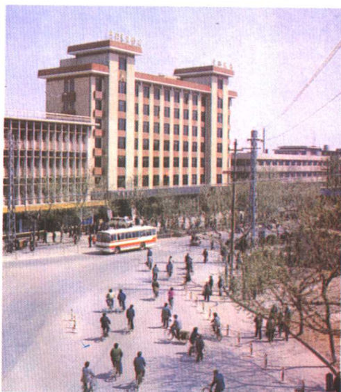
◀ 盐城金融大楼
