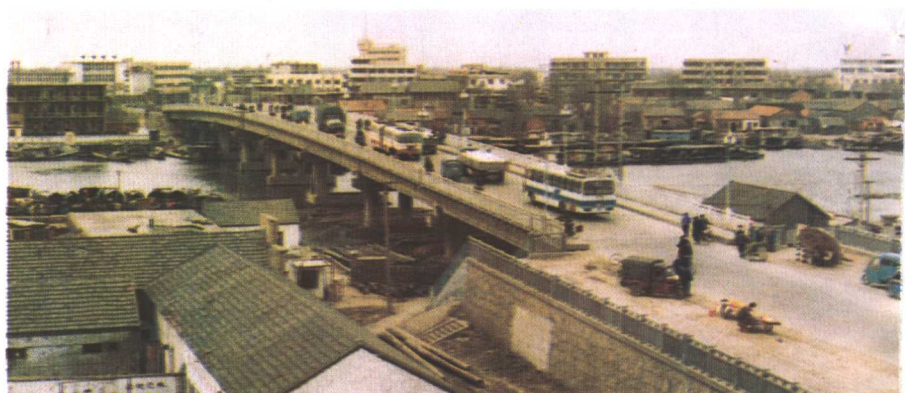
► 阜宁县城射阳河大桥
