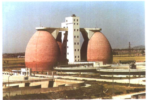
济南污水处理厂蛋型消化池
