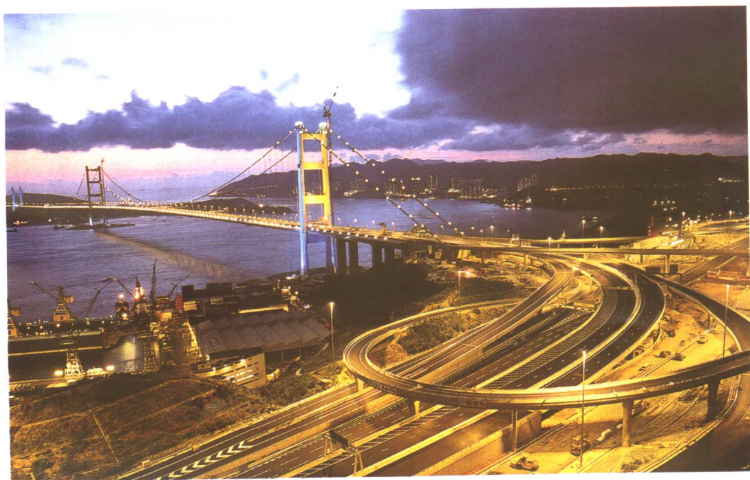
香港青衣交汇处高架天桥
