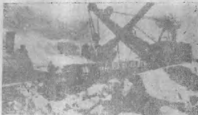
图7 1907年前后犹他铜矿的挖掘装载机。一些全回转式蒸汽挖掘机是从巴拿马运河工程购买的。
