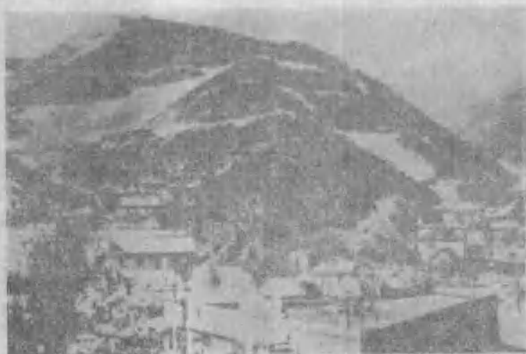
图5 1906~1907年间的初期露天矿开拓区
