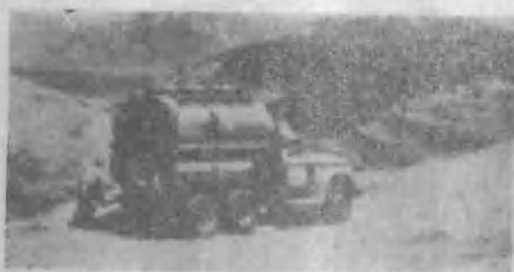
图10 浆状炸药的机械化装填和爆破
