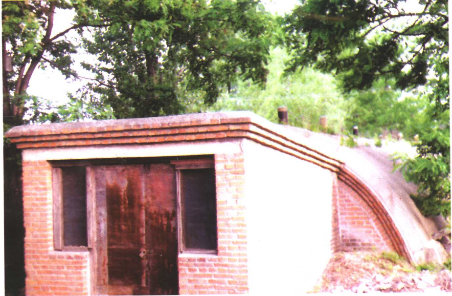
半地下式通风贮藏库外貌
