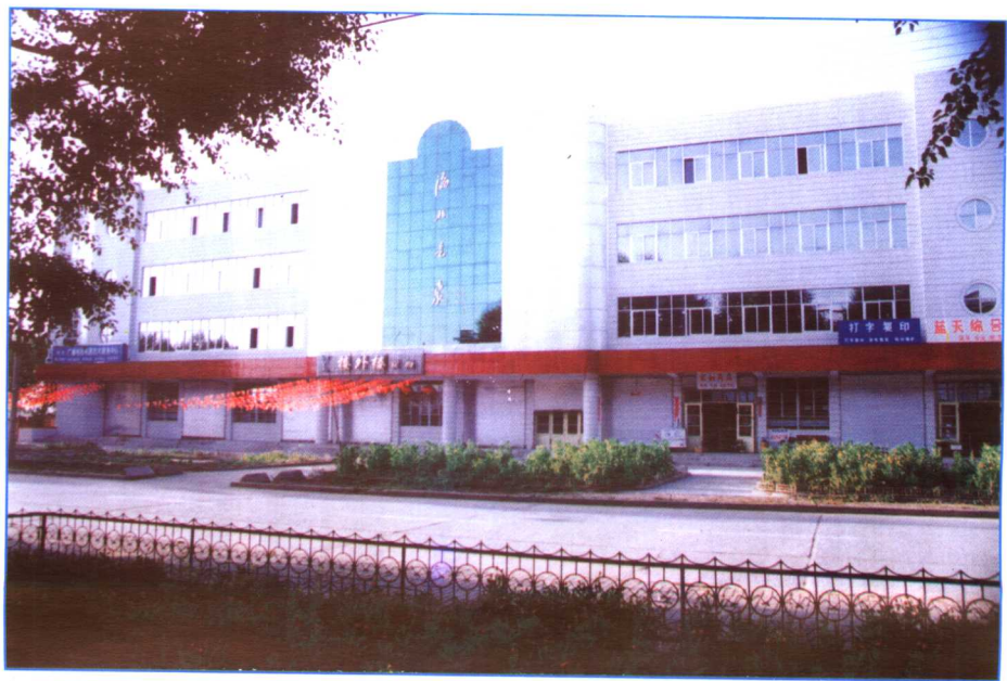
海北州气象业务大楼
