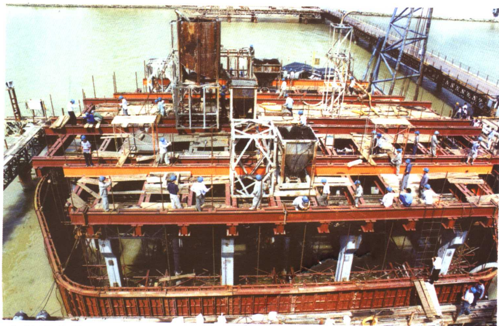
主墩承台施工
