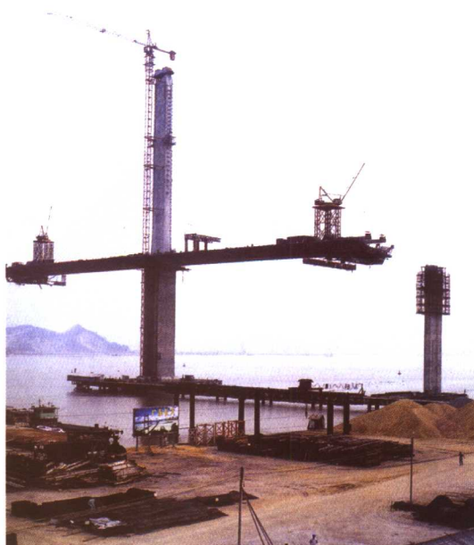
单索面挂篮悬浇施工
