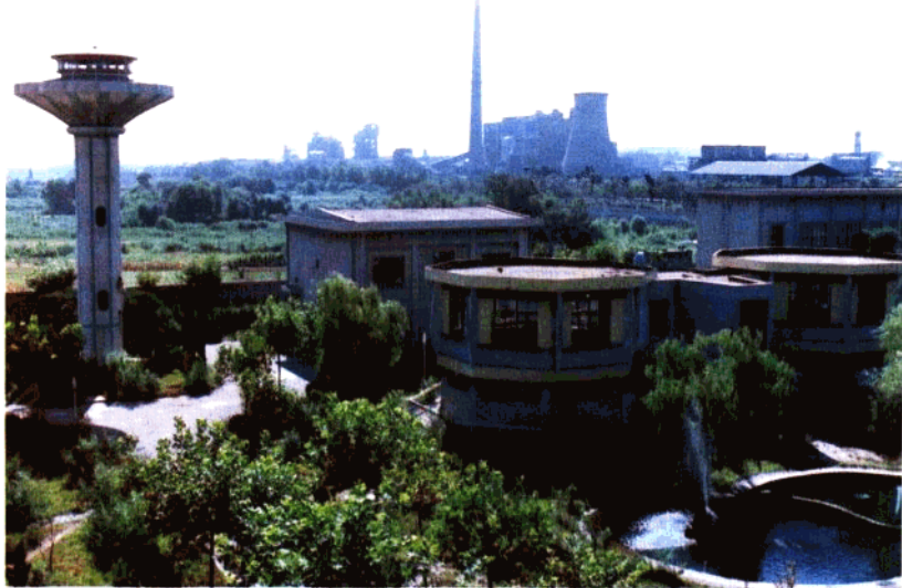
烟台合成革总厂采用先进的生化处理方法，对工业废水进行二次净化，工业废水排放合格率达94%。
