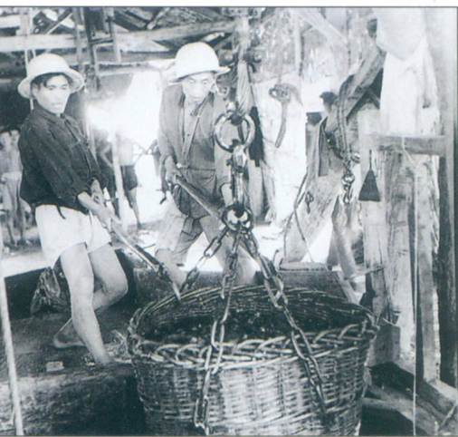
邹县煤矿建设伊始，自力更生，土法上马，以后逐步发展为半机械化生产。 当时采用条筐和牛皮包提升煤和水。
