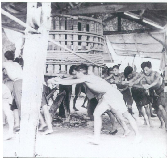
1958年9月23日，位于邹城西南7.5公里的邹县煤矿(地处牛庄)开工建设，开始提升工具为人力磨车。
