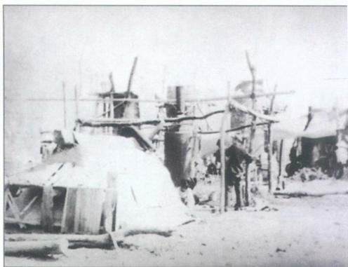
峰山人民公社在大炼钢铁中正在建造土高炉。
