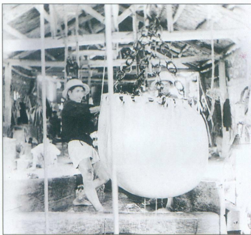
邹县煤矿建设伊始，自力更生，土法上马，以后逐步发展为半机械化生产。 当时采用条筐和牛皮包提升煤和水。
