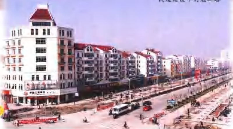
改造建设中的冠华路
