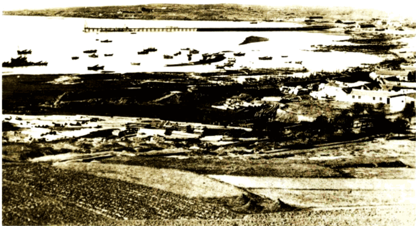
► 1901年5月1日，栈桥扩修工程竣工，“下立铁柱，上铺木板，置轨其上”，宽10米，长350米。
