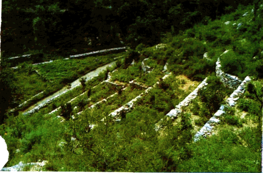
侯家庄岗底村 托么沟谷坊坝
