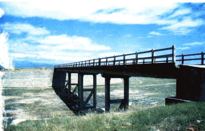
马河水库溢洪道工作桥
