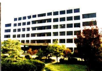
二建承建的县委办公楼 (市优工程)
