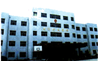
一建承建的工商局办公楼 (省优工程)
