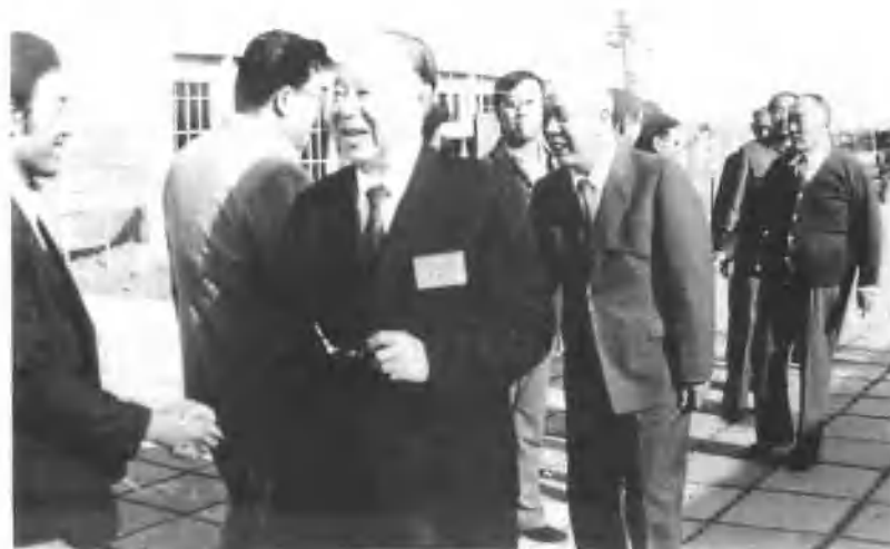
△1987年9月25日，全国人大常委会副委员长廖汉生(前左一)、全国政协副主席王恩茂(前左二)视察兵团工一师四团施工的北疆铁路呼图壁车站工地。
