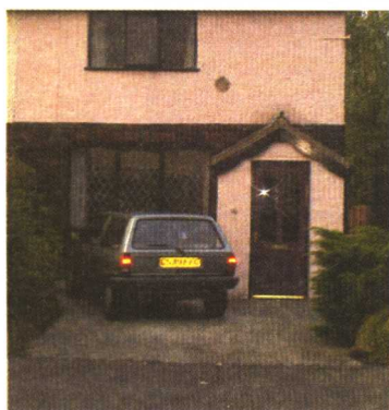
未漆之前房子外观。
