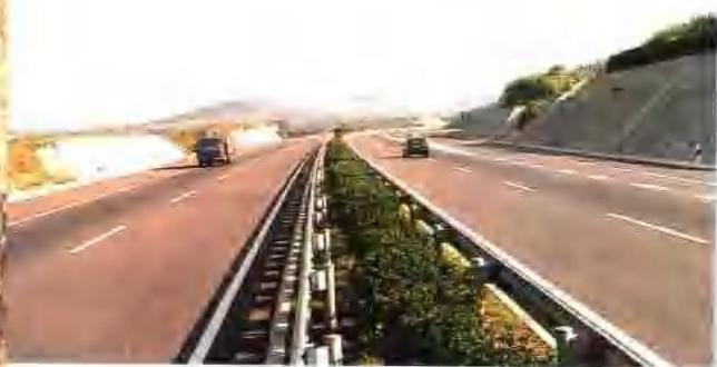
京沪高速公路沂南段一角
