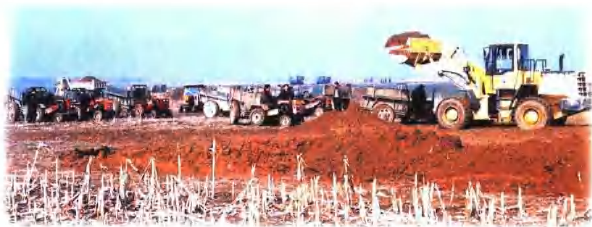
取土垫地工地
