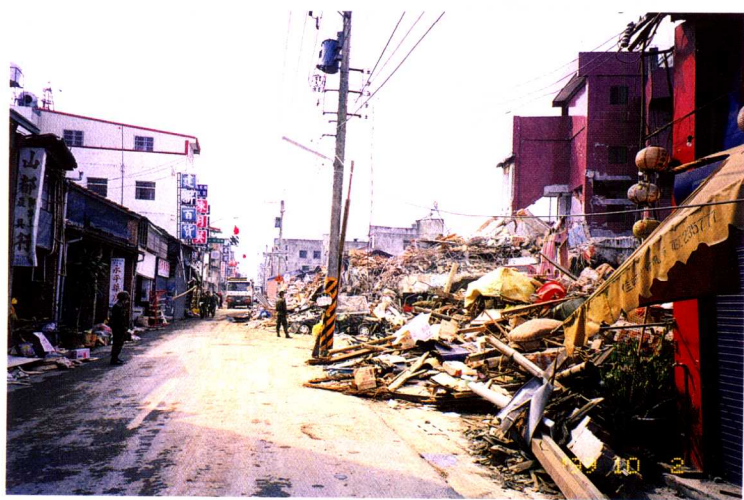
中寮鄉舊街老屋已成一堆垃圾
