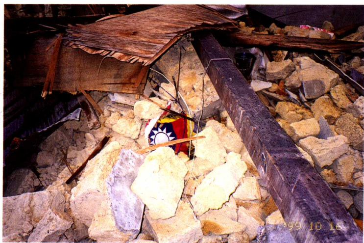
國姓鄉一棟災屋所攝，國旗也陣亡
