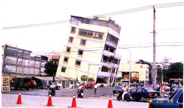
東勢鎮傾倒的一棟大樓
