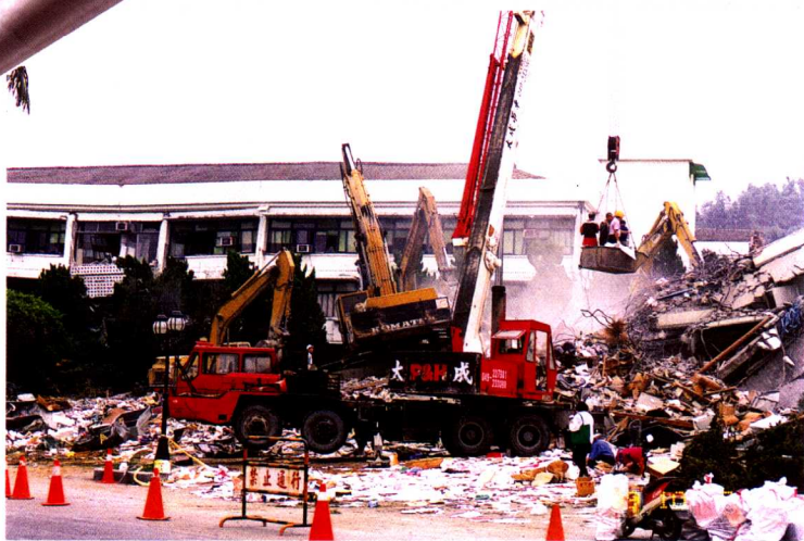
省府中興新村受損大樓正在拆除
