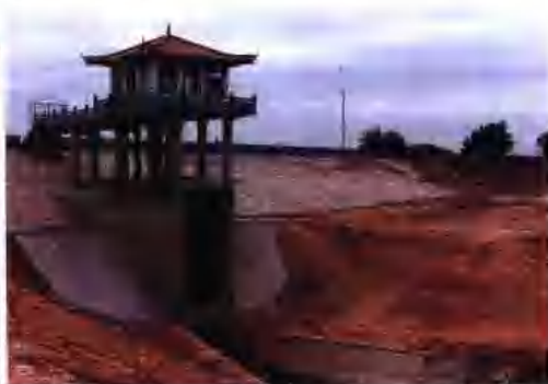
新建的日照水库放水洞
