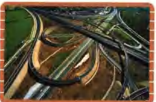
六环路西沙屯立交桥
