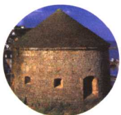
法国 贝森 海港防御工事
