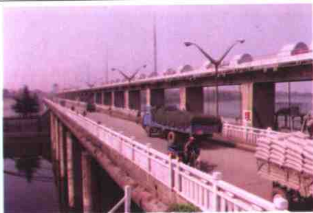
微山湖二级坝 节制闸全景
