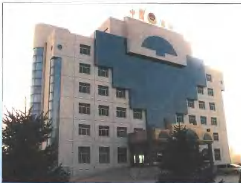
▲ 商检检测大楼
