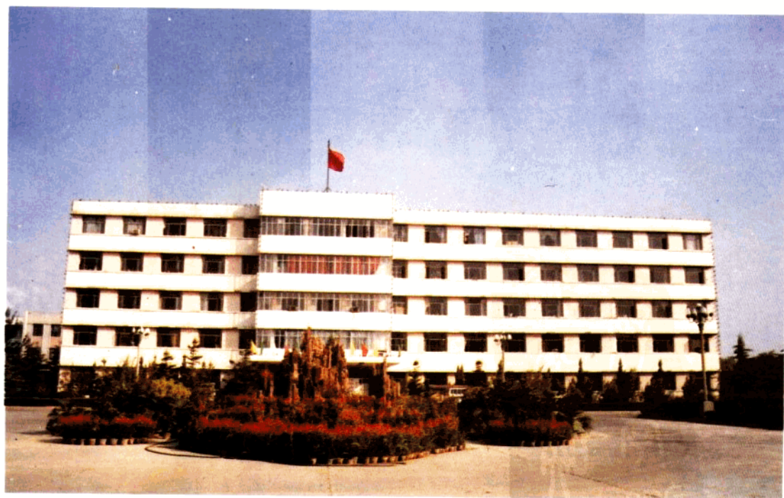
检修公司办公楼
