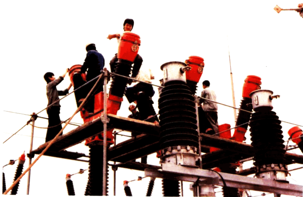
在橡胶厂110KV变电站施工
