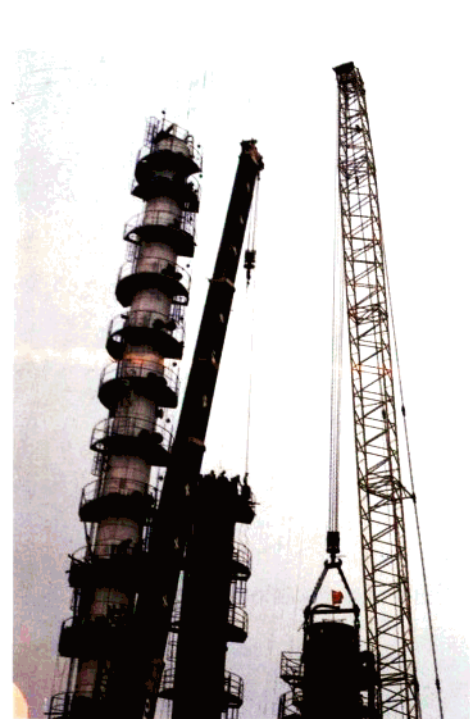
正在施工中的气体 丙——丙分离塔
