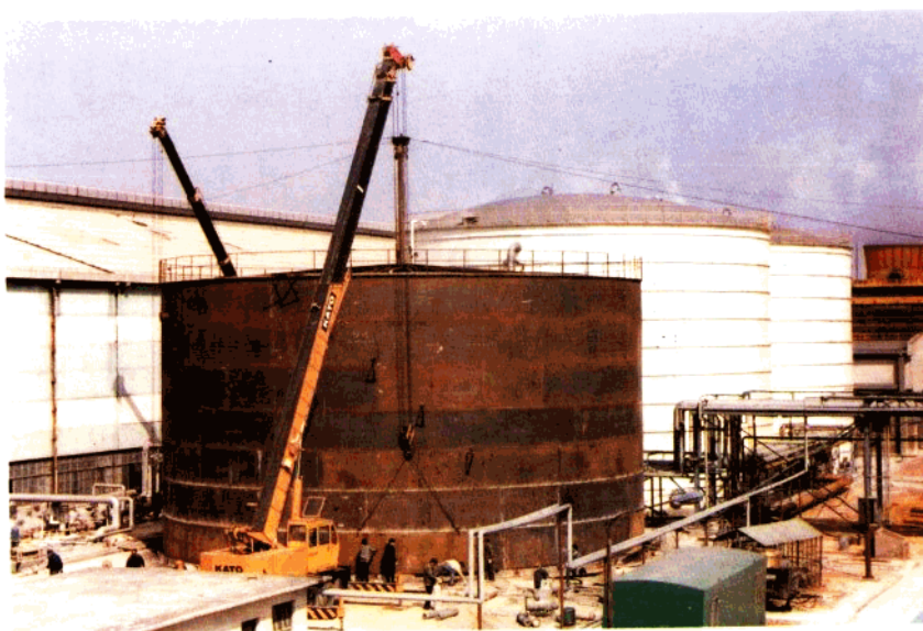
氯碱厂5400m 3 成品罐施工
