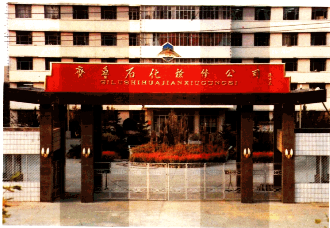
齐鲁石化公司检修公司
