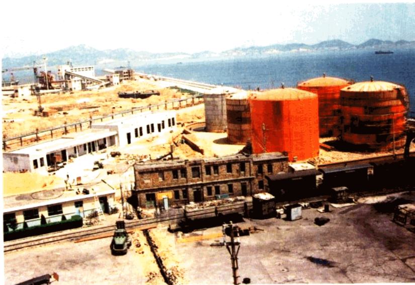
公司承建烟台港油品出口码头
