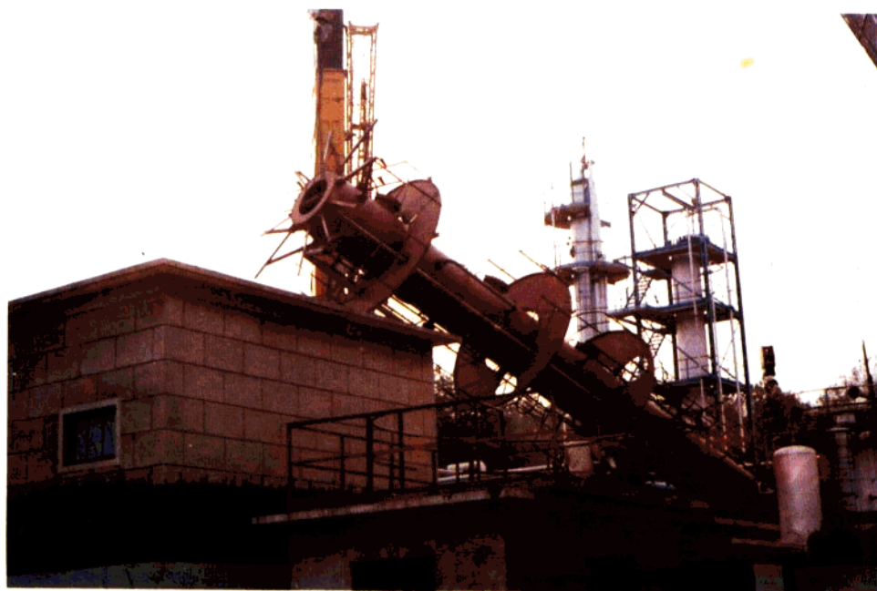
吊装炼油厂循环氢脱硫塔
