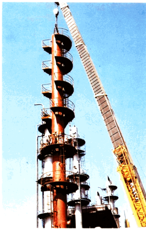
吊装橡胶厂03主项装置塔
