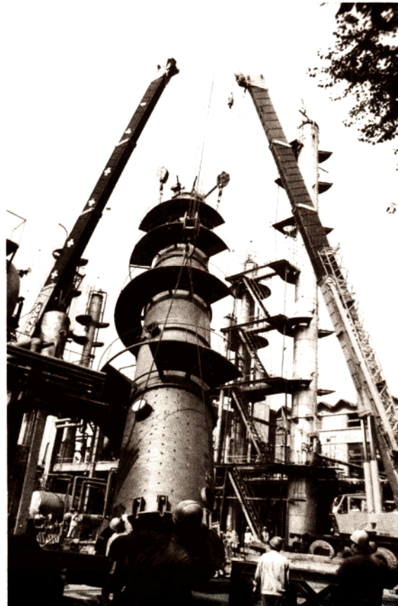
正在吊装的 炼油厂烷基 化塔
