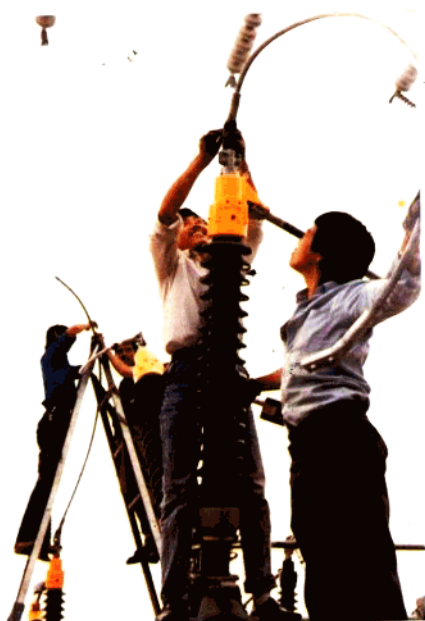
橡胶厂110KV变电站改造增容
