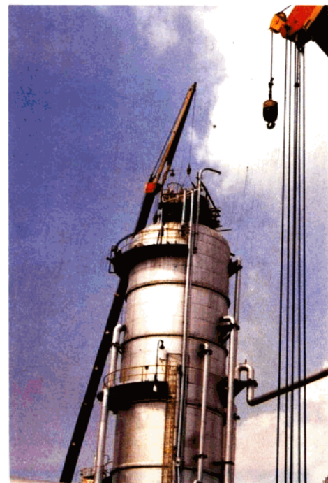
烯烃厂101塔吊装
