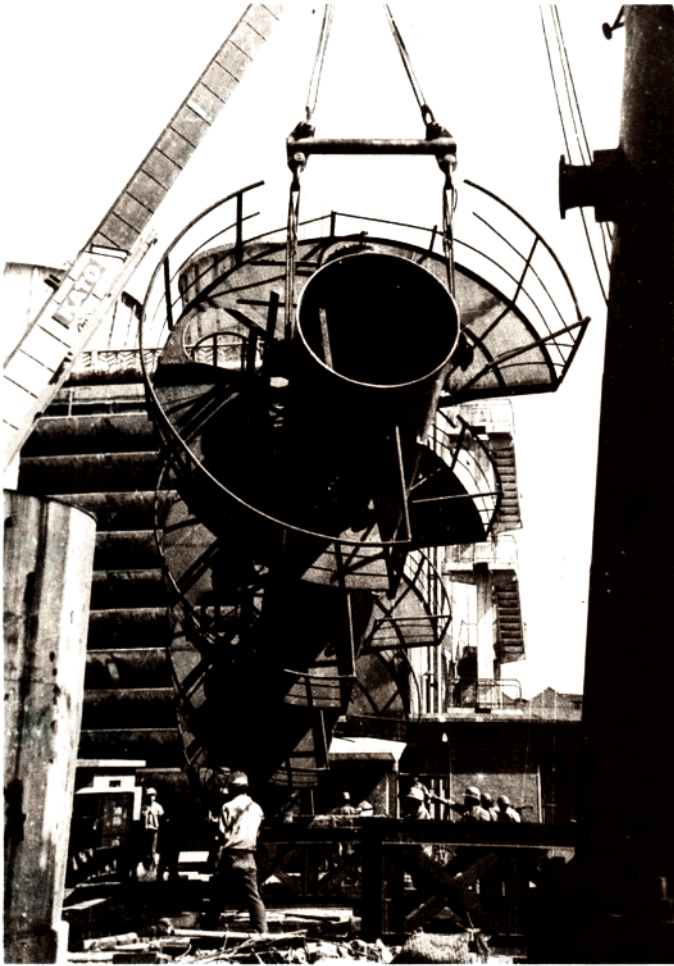
橡胶厂03主项改造工程
