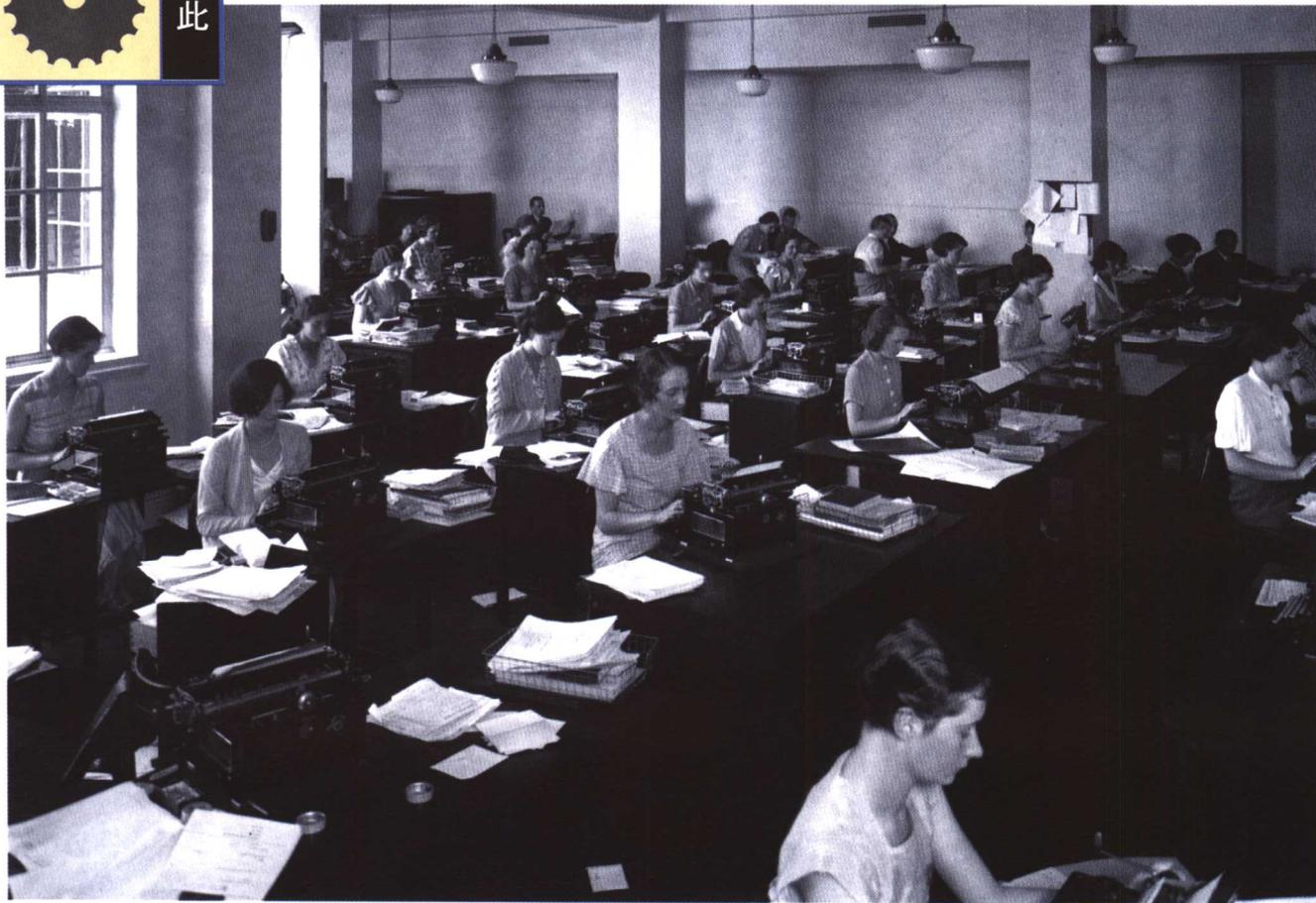
借用印刷机的金属铅字的思想，打字机（如上图）一次打一个字母使人们可以打出整洁的含有信息的页面。一个打字机由以下部件组成：键盘、末端带字母的锤、紧靠橡胶滚轴的托架——用于支撑纸张，并使其从一边移动到另一边，还有色带——一个灌注有油墨的织物卷轴。
