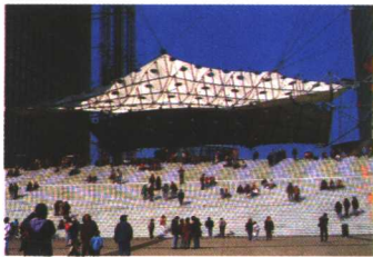
图2B 德方斯大拱门与人的尺度相适应的,建筑下部空间是人们交往活动的场所,建筑以象征手法强烈地表现建筑、环境与人的关系。下部空间的棚盖象征天空的云,巨大尺度的阶梯形基座象征山丘,棚盖下面形成一种自然品味浓厚的交往空间,棚盖最低处的空间高度不足6m,完全消除了这幢巨大建筑带给人们的冷漠感。
