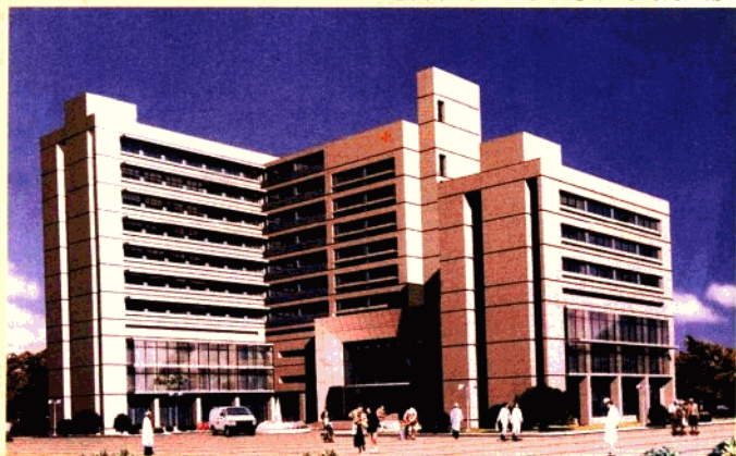
正在建设中的 1.6 万平方米的病房大楼
