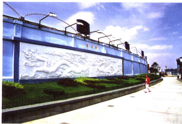
加固后的武汉龙王庙堤防
