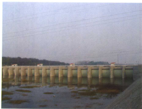
加固后的河南昭平台水库非常溢洪道
