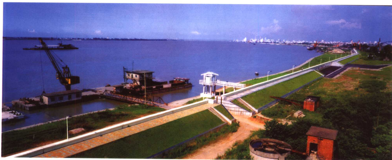
加固后的九江长江大堤
