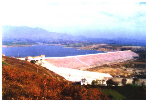
加固后的河南省孤石滩水库
