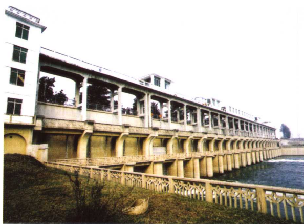
加固后的长江新堤闸
