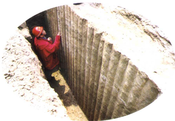
防渗墙开挖检测
