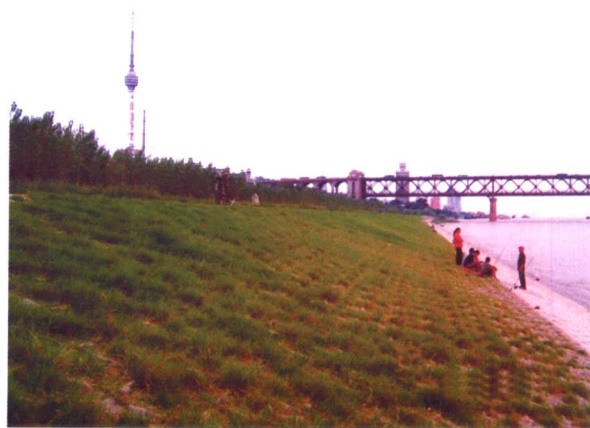
堤防植生块护坡
