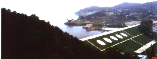
加固后的湖南王家厂水库大坝
