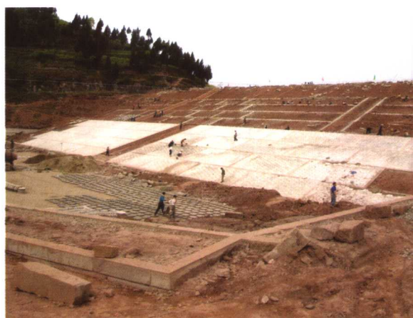
加固施工中的四川广安区七一水库大坝
