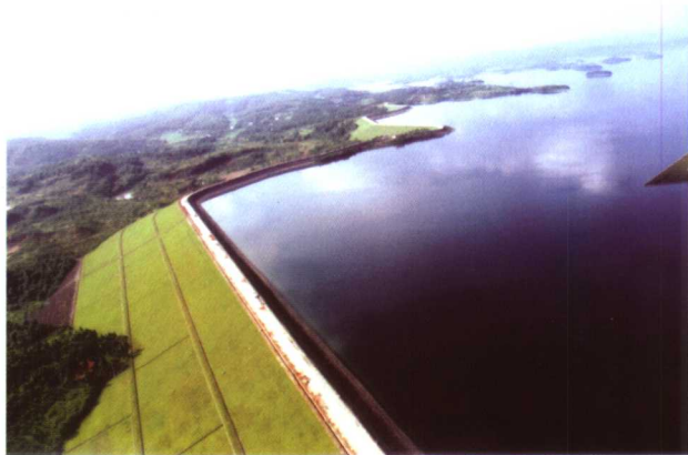
加固后的湖北省漳河水库
