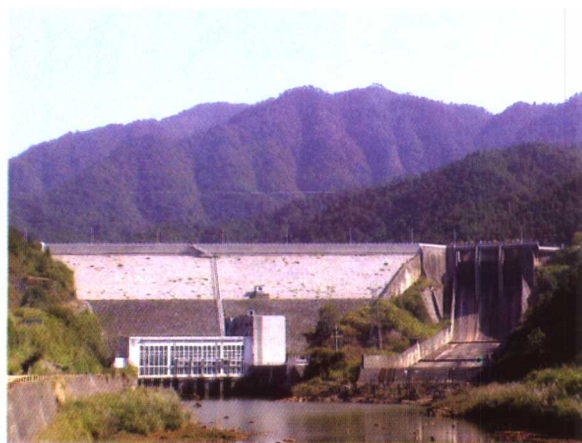
加固后的湖南株树桥水库面板堆石坝
