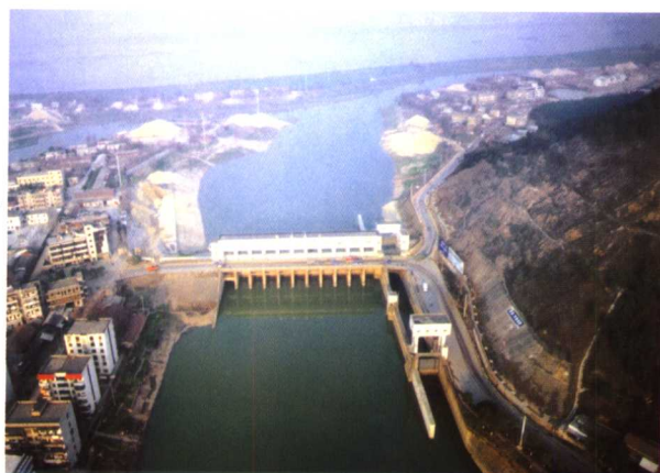
加固后的湖北鄂州樊口大坝
