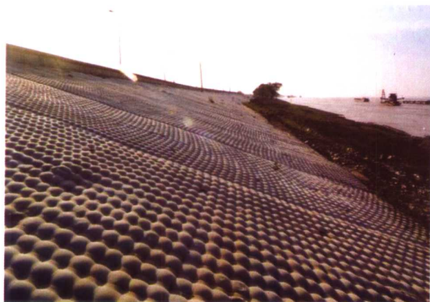
长江堤防模袋混凝土护坡
