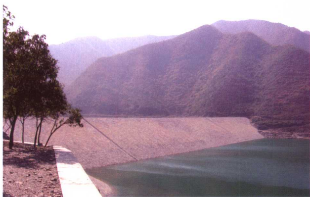
加固后的湖北省石门集水库
