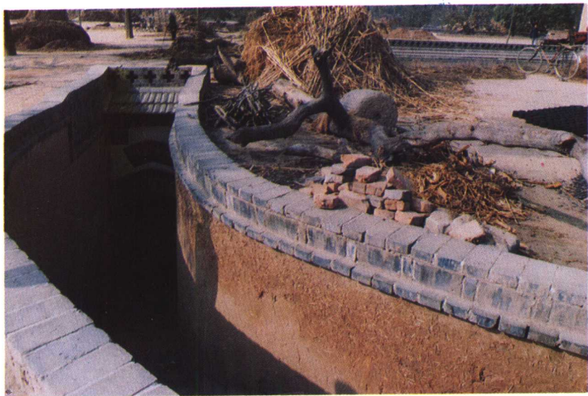
图 25 地坑院出入口——窑漫道
