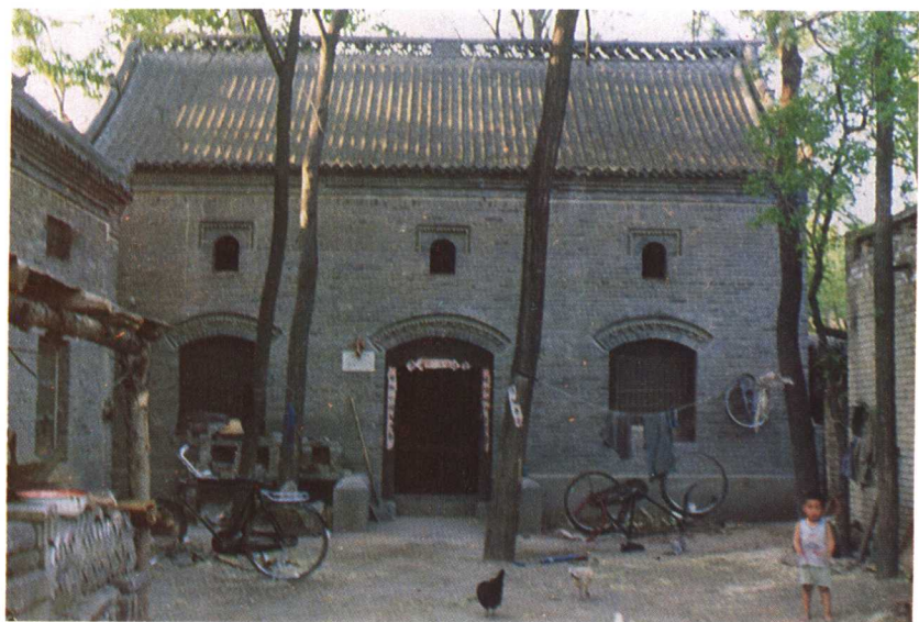
图 11 老式封闭型楼房
