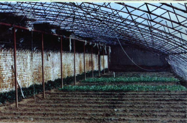
3. 有柱钢筋骨架温室
