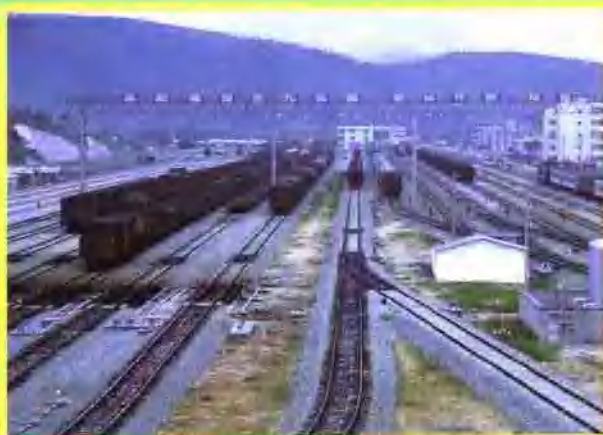
京九铁路华南地区最大的编组站——龙川北编组站
