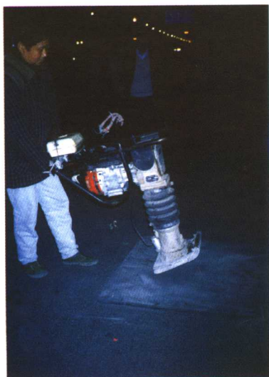
照片7 人工地震夜间施工
