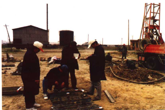
照片9 钻探施工现场
