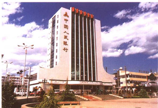
中国人民银行丽江市中心支行办公大楼
