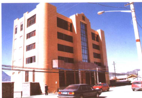
丽江市农村信用联社营业办公楼
