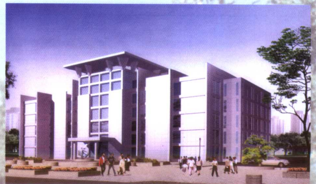
三江生化综合楼外景
