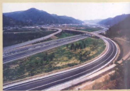
延(安)安(塞)高速公路
