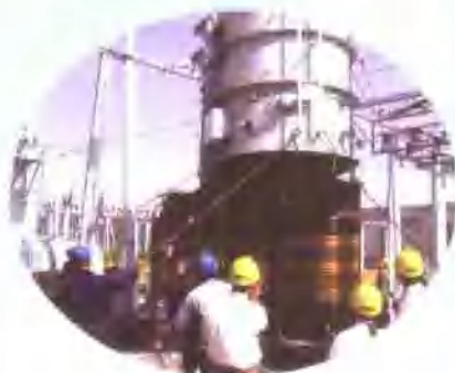
110千伏港尾变电站工程建设现场
