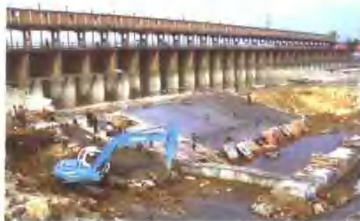
西溪桥闸除险加固工程
