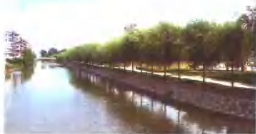
城市防洪建设——高坑驳岸工程
