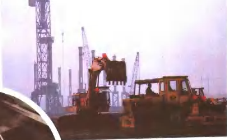
“三炼钢工程”开工
