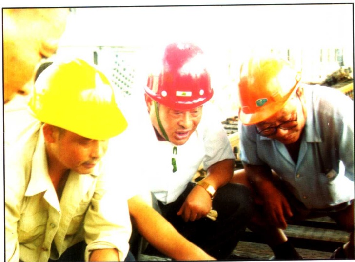
王名轸副市长（中）在施工现场检查施工质量。
