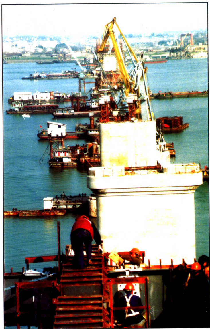
热火朝天的施工现场。(张作胜摄)
