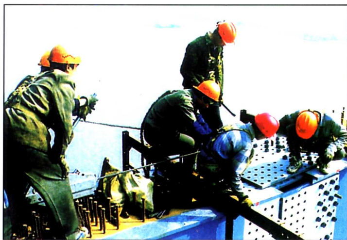
施工现场（大桥指挥部提供）
