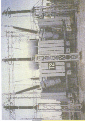
出口马来西亚 OSFSPSZ-200MVA/275kV 变压器
